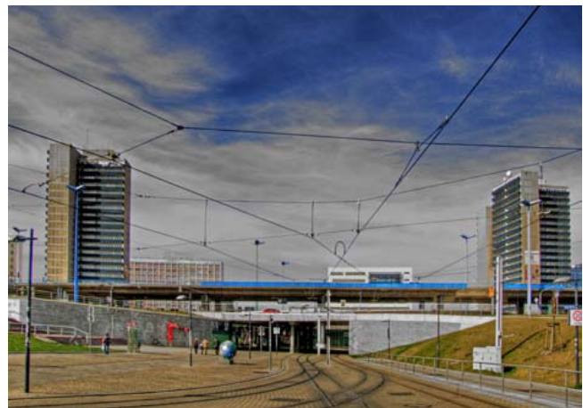
Die leeren Hochhäuser am Riebeckplatz, 2008
