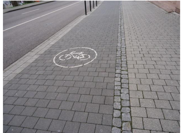
Bild 4: Radweg mit Pflasteroberfläche in der Straße Am Leipziger Turm
