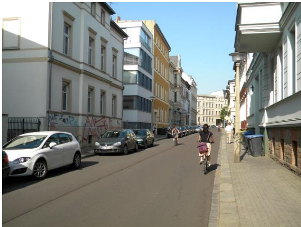
Bild 22: Asphaltoberfläche im östlichen Mühlweg
