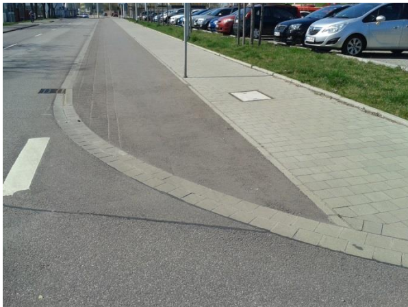
Bild 7: Radwegabsenkung auf Nullniveau in der Delitzscher Straße
