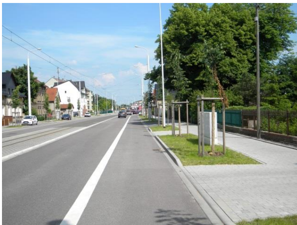
Bild 1: Radfahrstreifen in der Delitzscher Straße
