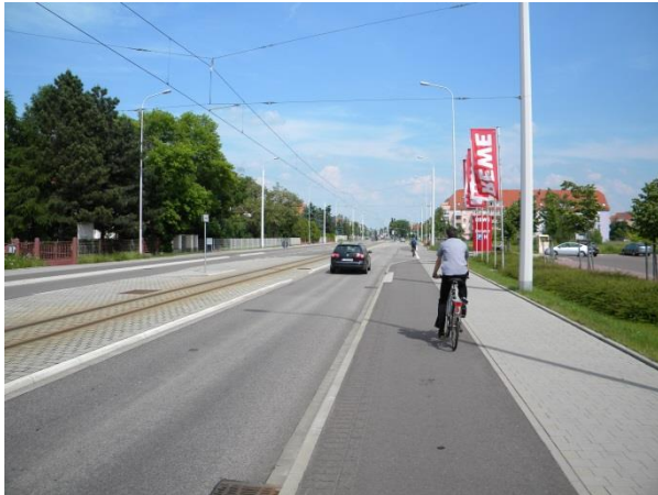
Bild 3: Radweg mit Asphaltoberfläche in der Delitzscher Straße
