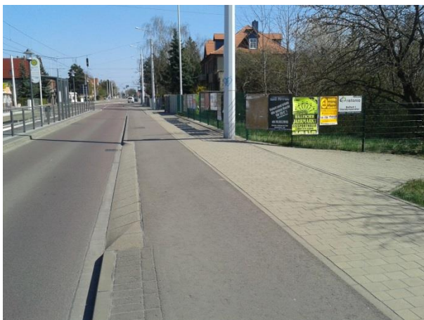
Bild 5: Ununterbrochener Radweg an einer Grundstückszufahrt in der Delitzscher Straße
