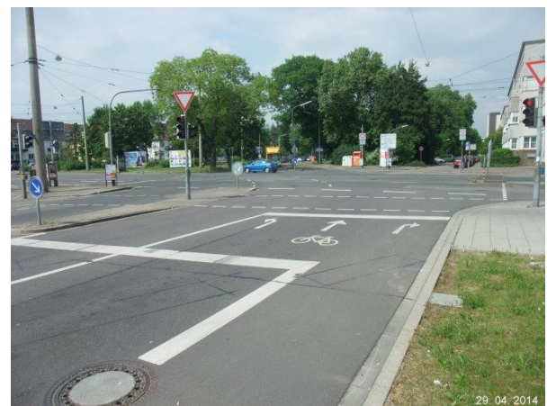
Bild 18: Direktes Linksabbiegen über einen aufgeweiteten Radaufstellstreifen (Karlsruhe, Schwarzwaldstraße)
