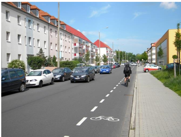
Bild 14: Einseitiger Schutzstreifen in der Robert-Koch-Straße
