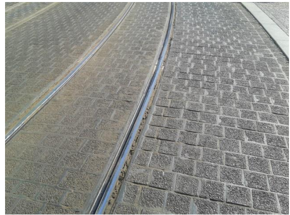
Bild 25: Pflasterbelag mit Straßenbahngleisen in der Schmeerstraße
