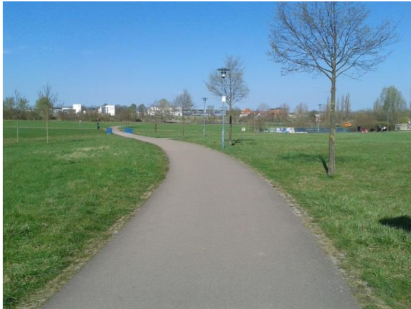
Bild 27: Weg mit Asphaltoberfläche im Grünzug Weinbergwiesen
