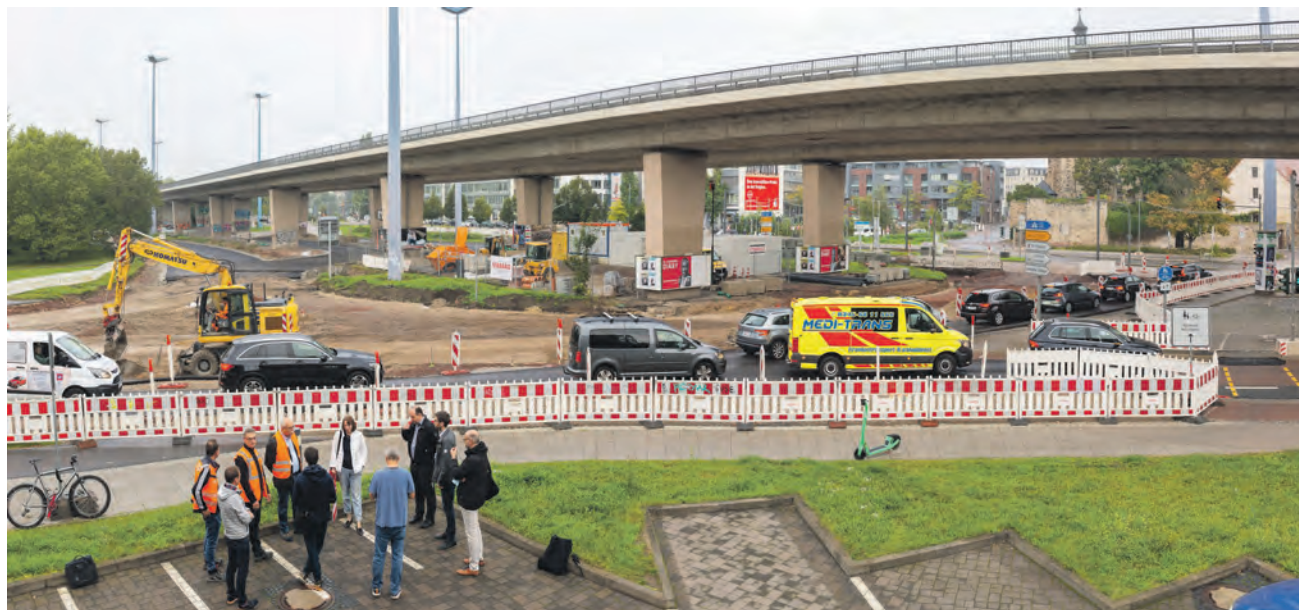
Der Glauchaer Platz wird seit Juli dieses Jahres saniert.
